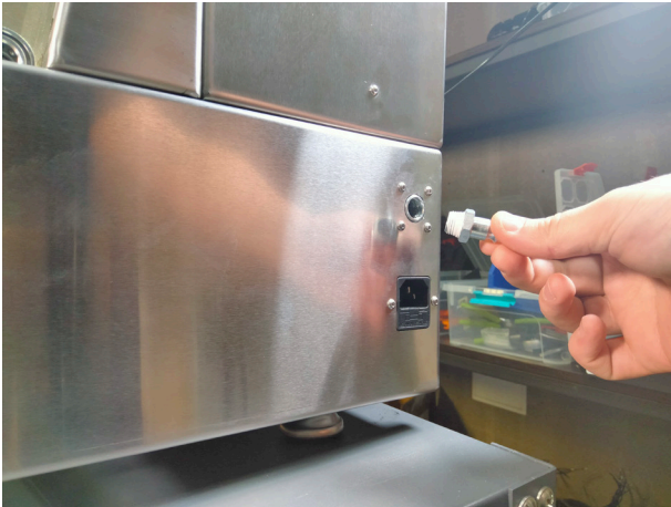
Рисунок 3. Монтаж штуцер швидкороз'ємного з'єднання для підключення джерела стисненого повітря
